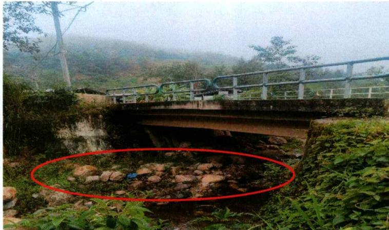
FIGURA N°02: PUENTE CATTIS (10 m) CON COLMATACION DE ROCAS Y EXPUESTO AL GOLPE EN CRECIDAS POR LLUVIAS PROPIAS DE LA ZONA
